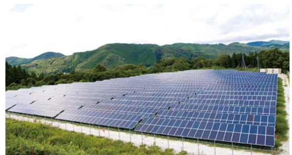
2013年に開設した出力1MW(1,076kW)の太陽光発電所
